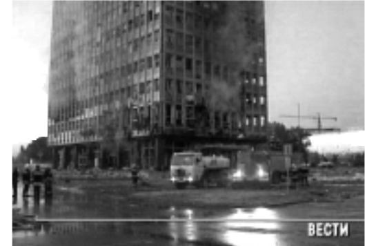
Ausgebranntes Büro- und Geschäftshaus
